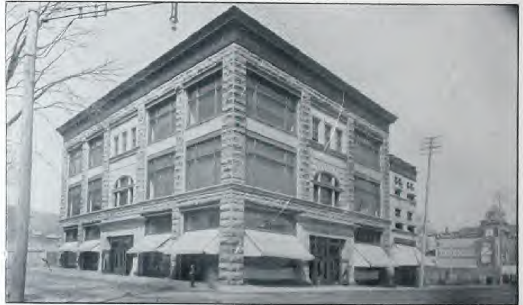
Fig. 186.—Jas. A. Ogilvy & Sons' Store, Montreal.
